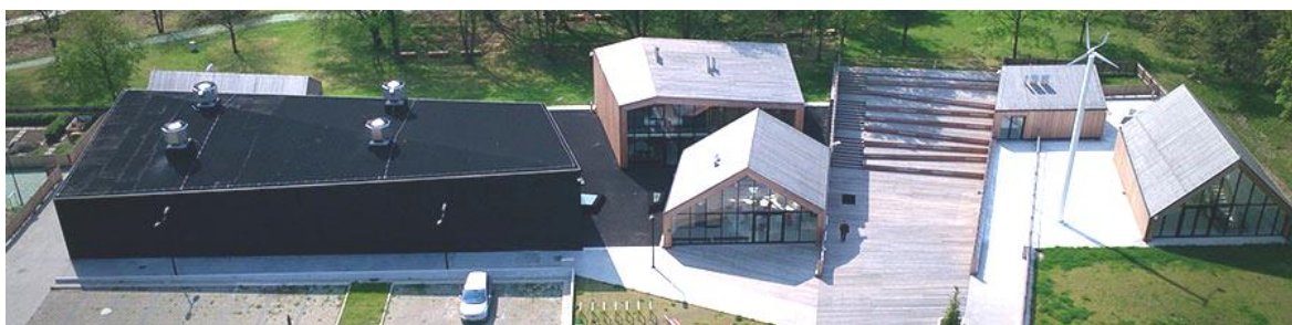
Główne budowle naziemne SDK . Mój spektakl autorski odbył się w środkowym, szczytem ustawionym i bardzo przeszklonym pawilonie. Bezpośrednio z niego schody prowadzą do obszernego podziemia, w tym do kąca bufetowo-kawiarnianego. Fot. SDK
